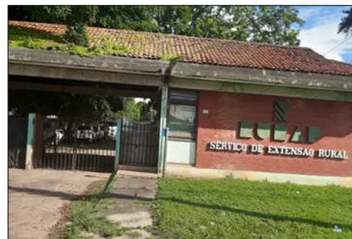
6º: Prédio do RURAP no início da BR-156
